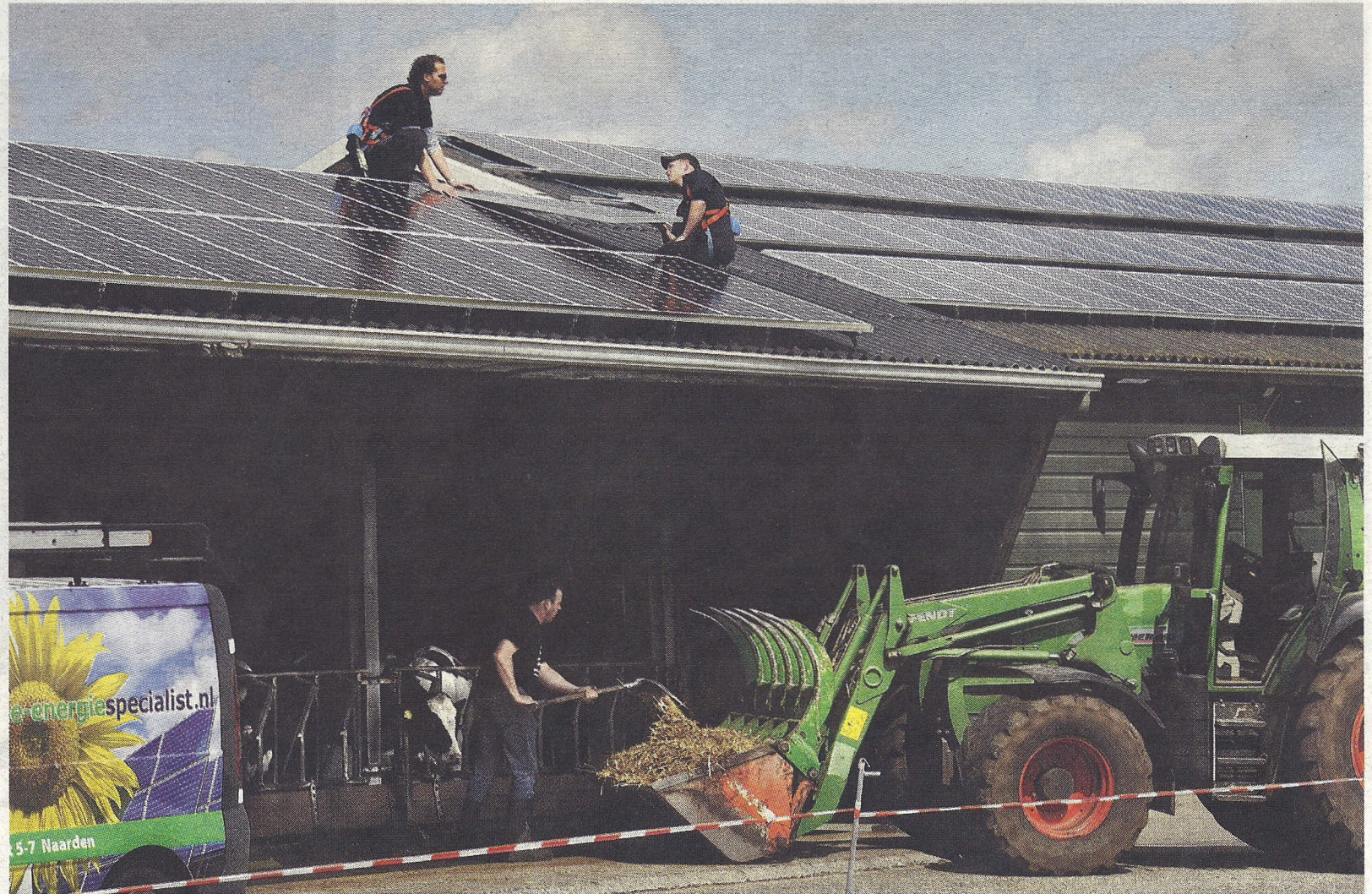
Terwijl veehouder Pieter Kuijer in Soest zijn koeien voert, brengen medewerkers van de Zonne-energiespecialist panelen aan op het dak van zijn boerderij. Kuijer is een van de twaalf veehouders in Eemland die hebben besloten zonne-energie te gebruiken.
